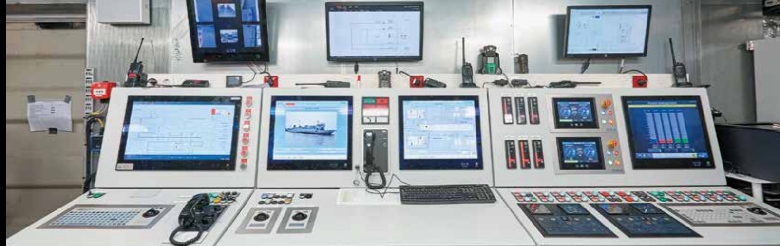
Aby zapewnić członkom załogi wgląd we wszystkie funkcje promu, w centrali kontrolno-manewrowej wielkie ekrany dotykowe zostały zintegrowane z systemem TP firmy Rittal.
