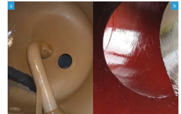
Fot. 5. Ochrona przeciwkorozyjna kompozytowymi powłokami Belzona®: a) zbiornika magazynowego chemikaliów, b) kanału wylotowego kwaśnych spalin
