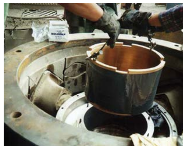
Fot. 3. Osadzenie tulei w oprawie na BELZONA® (1321) – wzmocnienie konstrukcji
