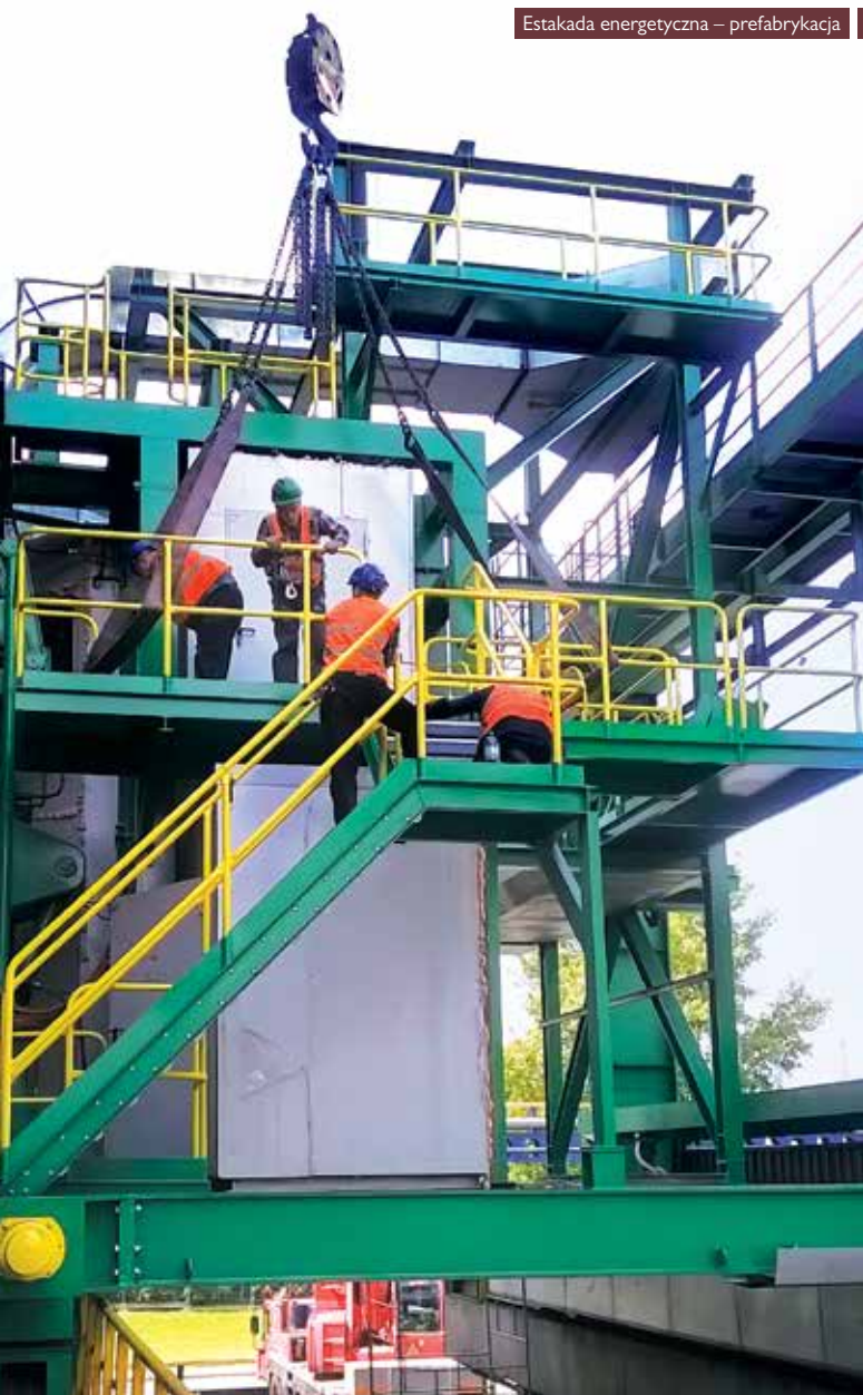
Estakada energetyczna – prefabrykacja
